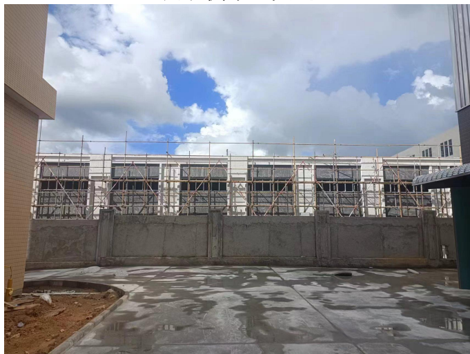
东北侧在建厂房
